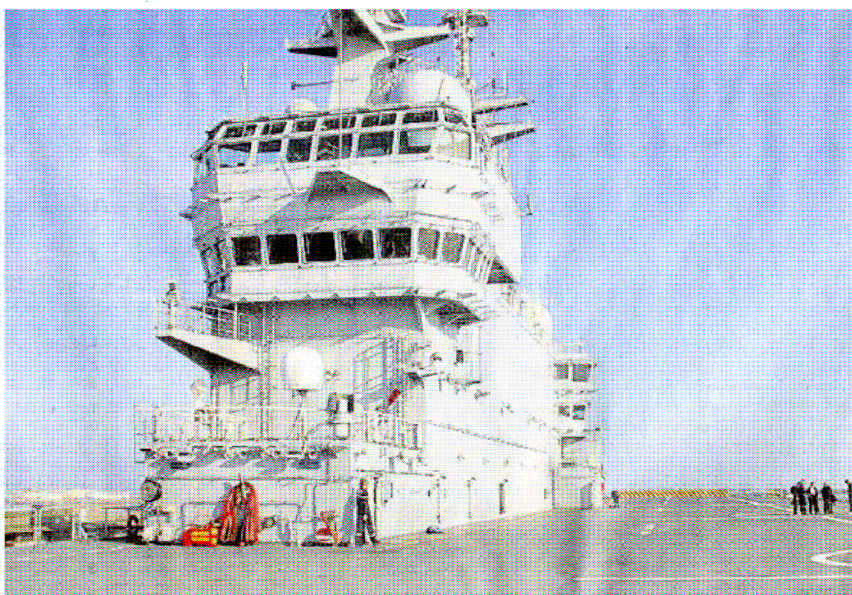
L'îlot du BPC culmine à 36 mètres au-dessus du niveau de la mer. La passerelle est située juste au-dessous des radars.
